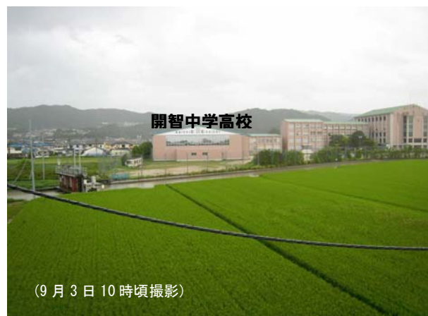
写真 2.4-2 平成23年9月(台風12号)洪水時の直川地区
