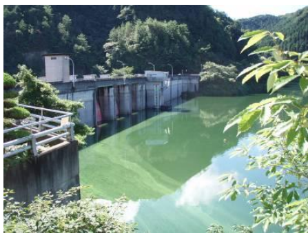
写真1 ダムサイト付近
