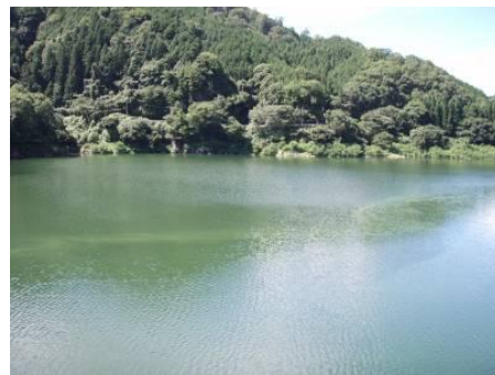
写真2 初瀬取水塔上流付近
