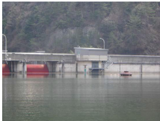
図 5.6.3-11 深層曝気設備
