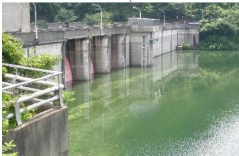
写真1 ダムサイト付近
