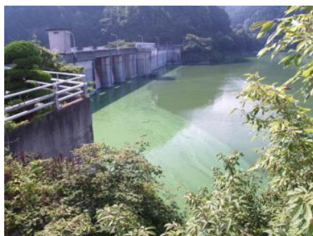
写真1 ダムサイト付近
