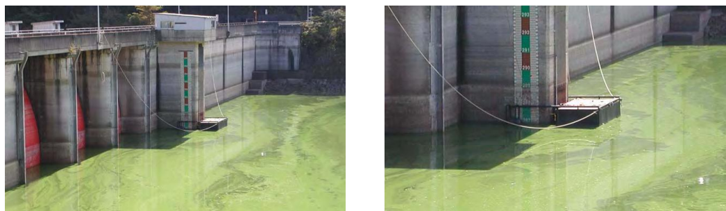
図 5.6.1-2 表層取水設備の簡易改良の現地状況
