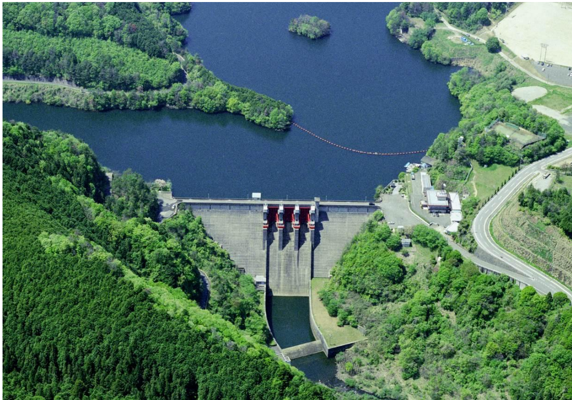
図 1. 2. 3-1 室生ダム全景
