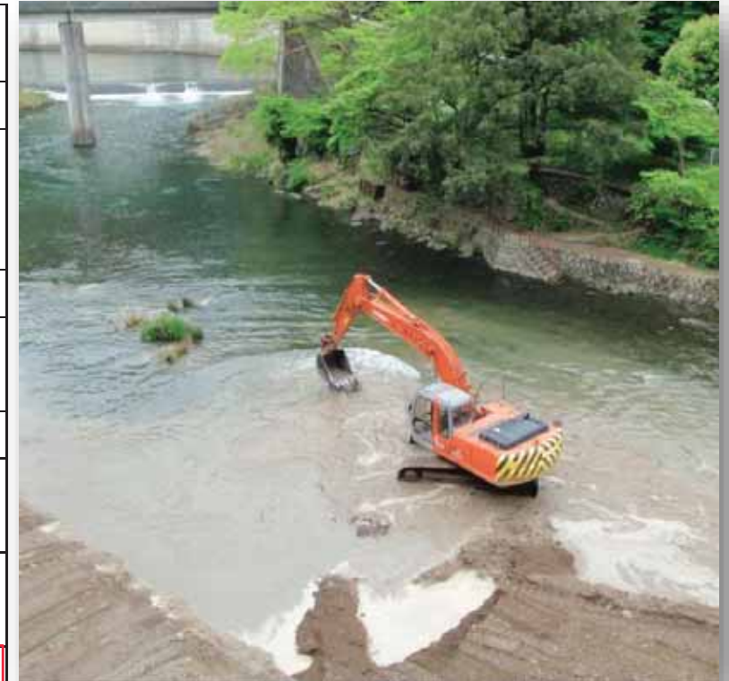
土砂投入の状況 平成25年5月10日
