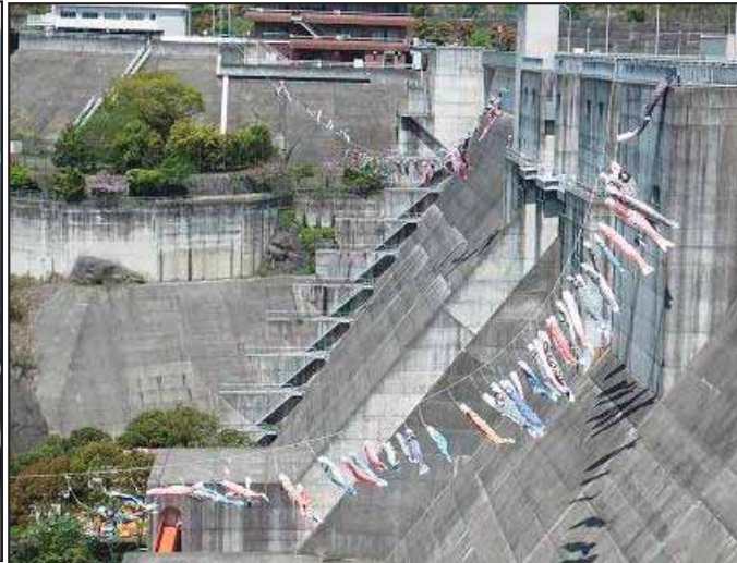
ダム堤体に設置した鯉のぼり
