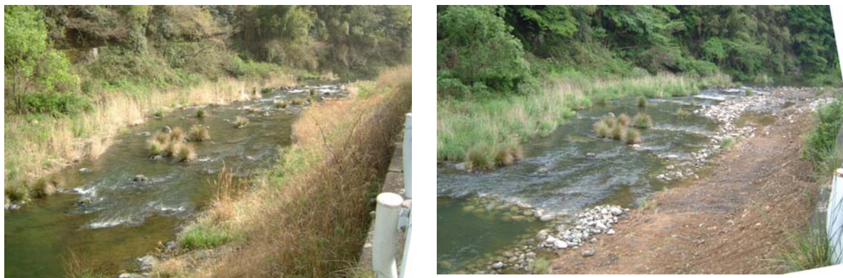
写真 6-6-2-1 ヨシの除去と玉石の投入対策前(左)と対策後(右)の状況
