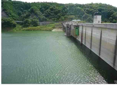
① ダムサイト選択取水設備付近
