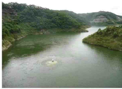
② りんどう橋下流側貯水池
