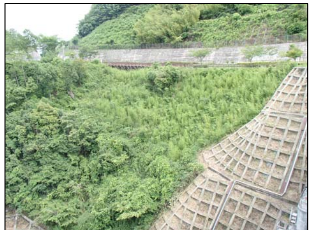
完成後状況 (H25. 6. 30)
