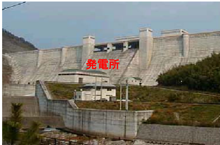
写真 3.2.6-1 比奈知発電所
