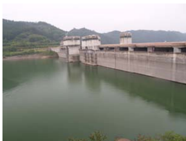
写真1 ダムサイト付近
