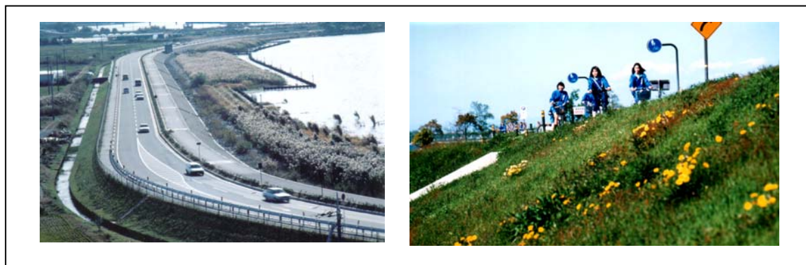
図 7.4-16 湖岸堤・管理用道路の利用状況
