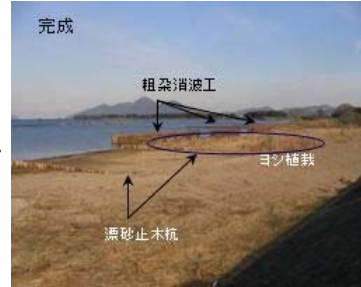
粗朶消波工とヨシの植栽により地盤の安定化を行う (2007年(平成19年)12月時点)
