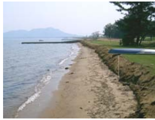
b) 2号突堤より西側の状況
