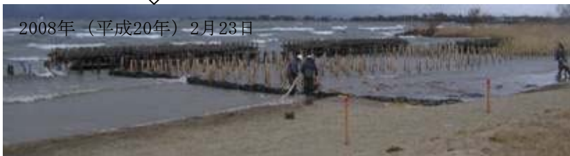
[粗朶消波工とネット蛇籠による漂砂防止堤を設置]
