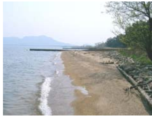
a) 1号突堤より西側の状況
