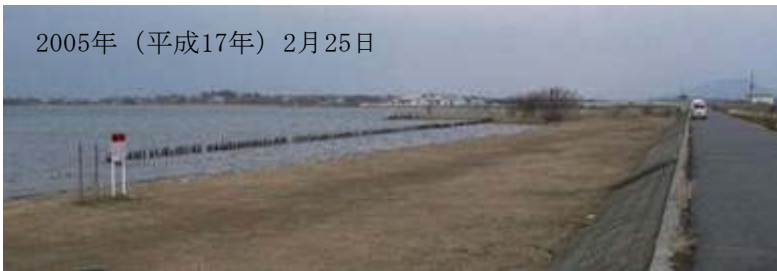
[1989年(平成元年)にヨシの植栽を実施したが、消波工の一部である木杭のみが残っている状況]
