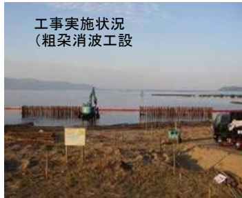
粗朶消波工とヨシの植栽により地盤の安定化を行う (2007年(平成19年)12月時点)
