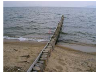
c) 3号突堤の状況
