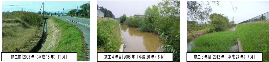
図 6.3-8(2) 吉川堤脚水路の経年変化
