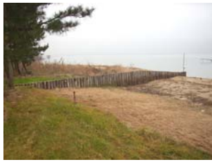
d) 1号突堤の改良状況
