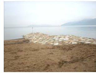
f) 3号突堤の本設状況
