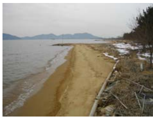
g) 1号突堤の本設状況 ：H21.11
