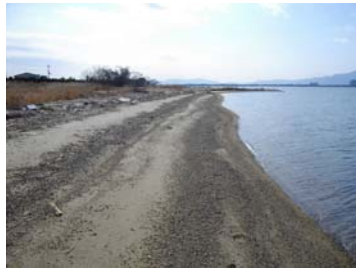
b) 2号突堤より北側の状況
