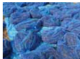
ブルーシート等に応じて乾燥(ネット等の飛散防止対策)
