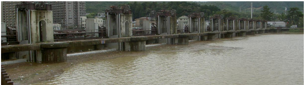
図 1-6 瀬田川洗堰全閉状況（上流左岸より）
