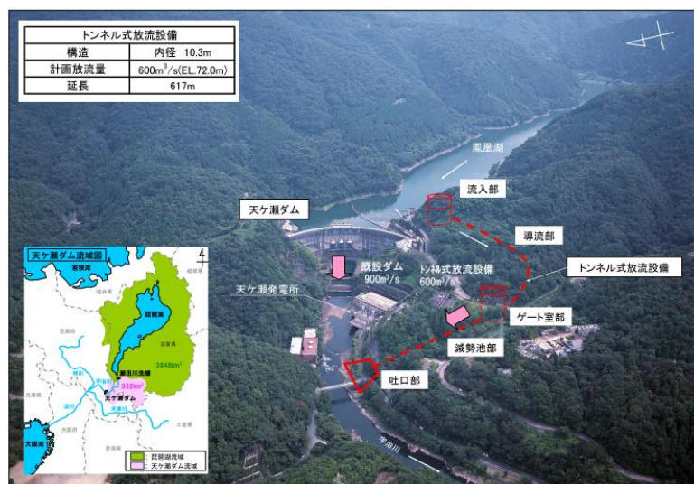
図 1.2-8 トンネル式放流設備概要図(イメージ図)
