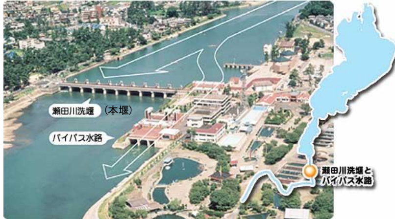
図 1.3-7 瀬田川洗堰バイパス水路
