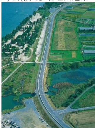
(a) 湖岸堤・管理用道路の建設
