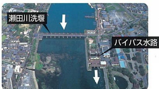
(f) 瀬田川洗堰の改築
