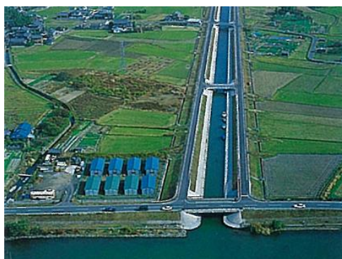
(c) 湖岸堤関連河川の改修
