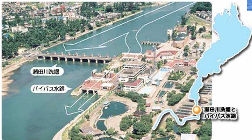
瀬田川洗堰バイパス水路
