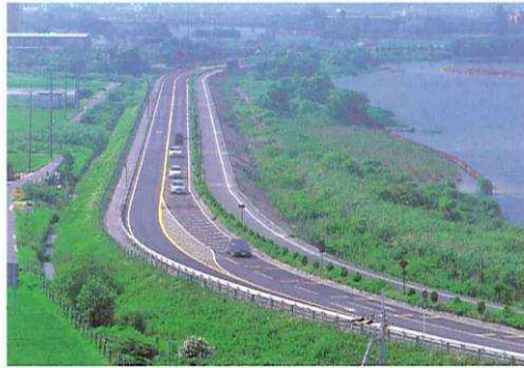
湖岸堤・管理用道路(草津地区)
