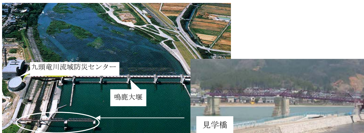
図 7.4-4 一般解放区及び見学橋の外観
