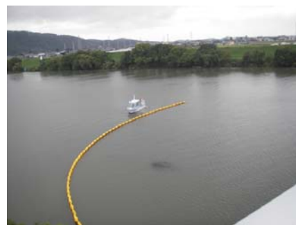
※15.6k高屋橋下流 (オイルフェンス設置状況)
