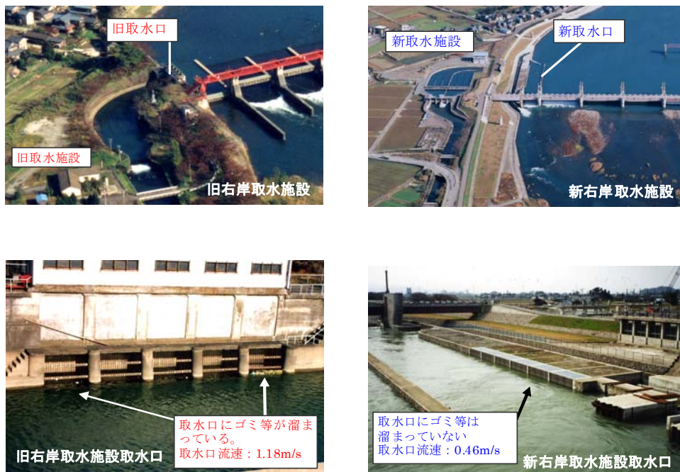
図 3.3-9 鳴鹿大堰及び鳴鹿堰堤の右岸取水施設
