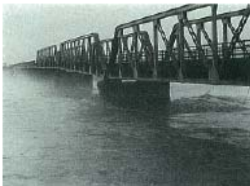
高屋橋の橋脚が傾く(県道福井三国線)
