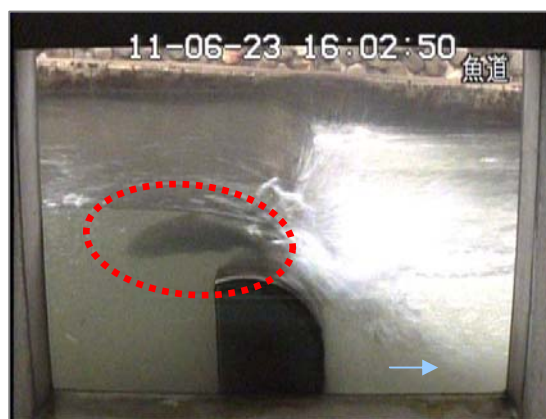
図 6.3-33 階段式魚道を遡上するサクラマス(平成23年6月)
