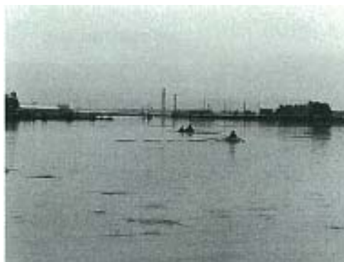
坂井市三国町下西付近の浸水状況
