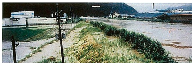
堤防からあふれ出す状況（浅水川右岸 JR 北陸本線下流付近）
