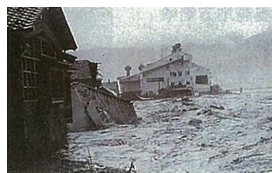
勝山市遅羽町比島付近
