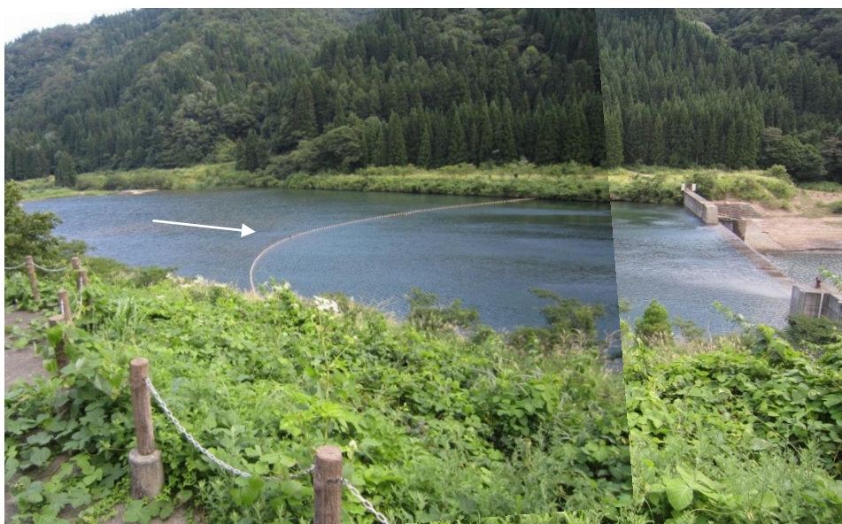
写真 4.4-1 副ダム湛水池の状況 (H25.8 月撮影)
