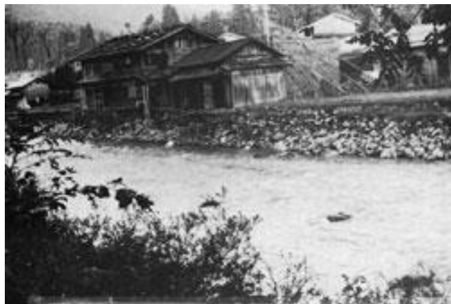
大野郡和泉村板倉付近
