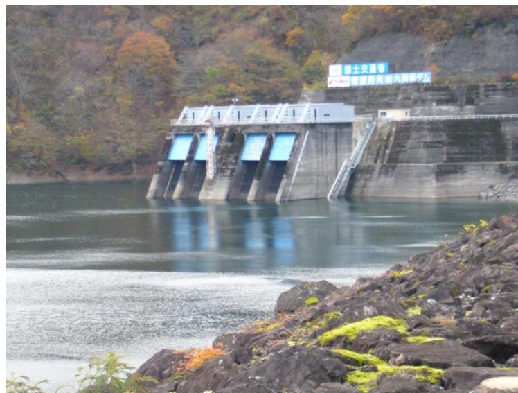
写真 3.2- 九頭竜ダム発電取水部
