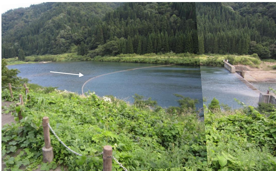
写真 4.4-1 副ダム湛水池の状況 (H25.8月撮影)
