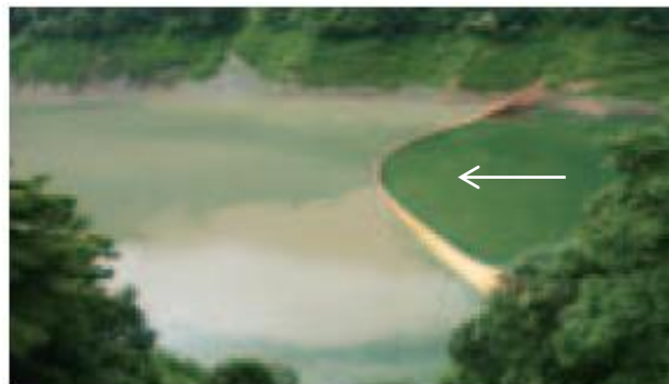
図5.6-3 濁水防止フェンス（洪水後、沈操作前）
