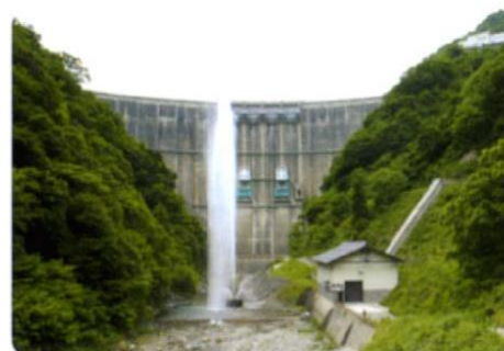
写真 3.4-2 噴水によるダム直下放流の様子
