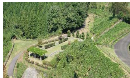
ダム右岸下流広場
