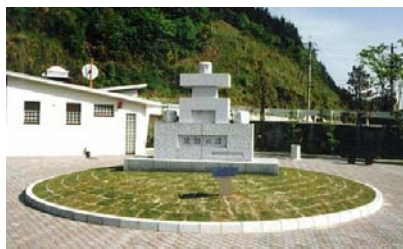
ダム左岸広場
