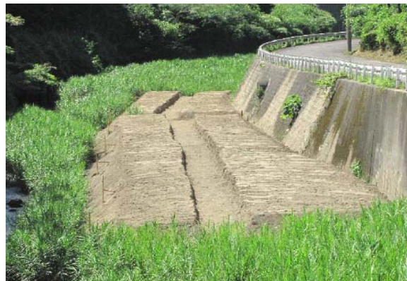
写真 下流河川への土砂供給 (土砂還元)
