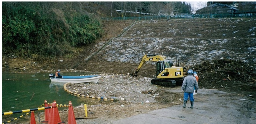
図 2.6-3 流木塵芥等揚陸状況
