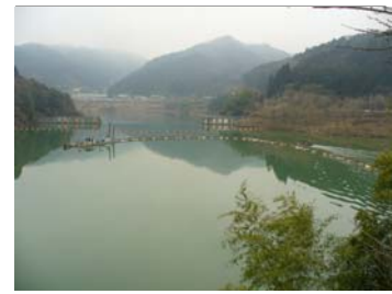
ポンプ浚渫状況(H19)
