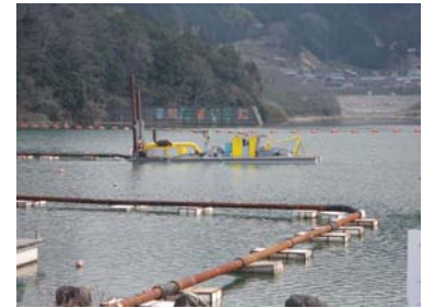
ポンプ浚渫状況 (H22)
