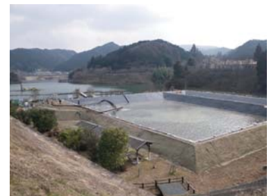
浚渫土沈殿作業 (H22)
