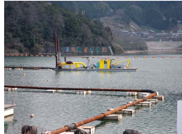
ポンプ浚渫 (H22)
