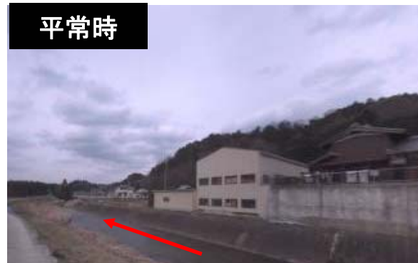
おうじ 写真 邑地地区(ダム下流3.7km地点)
