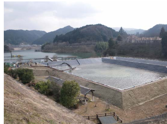
浚渫土沈殿作業 (H22)
