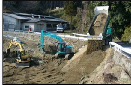
道路拡幅工事
