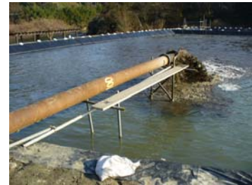
浚渫土沈殿作業(H19)
