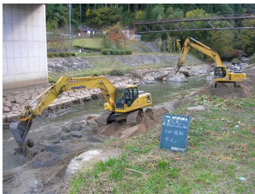
写真 堆砂掘削状況 (左：陸上掘削 右：水上掘削)
