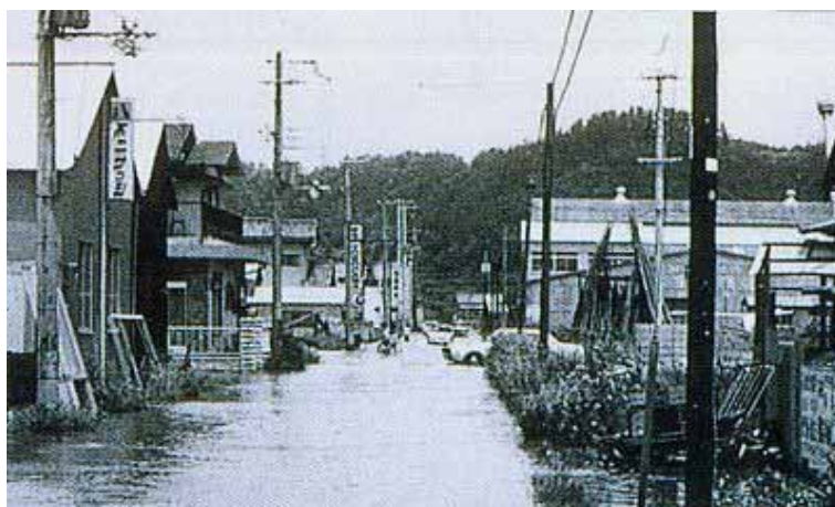
昭和49年7月 台風8号による水害の状況
