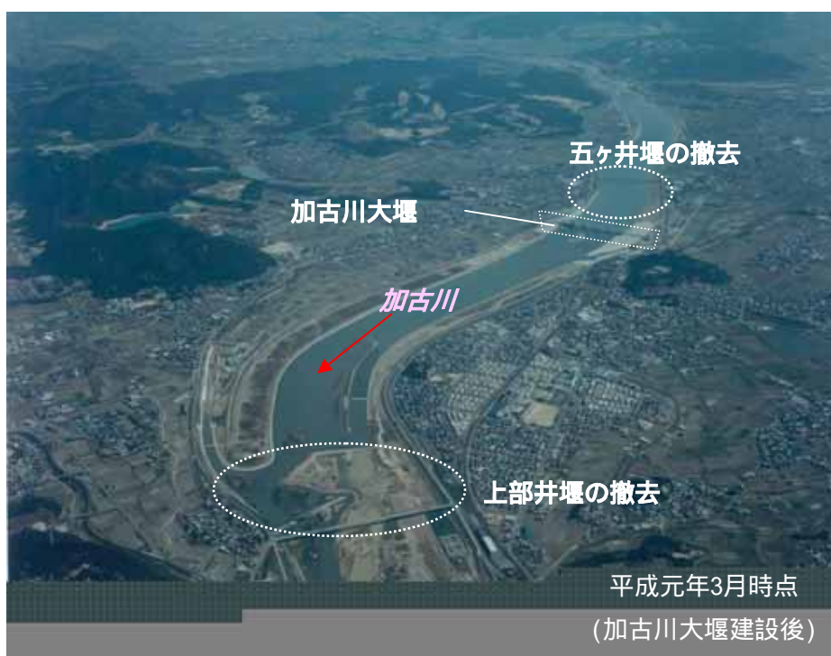
図1.2-3 井堰の統合の状況
