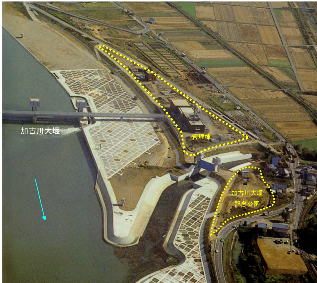
加古川大堰周辺環境整備の状況
