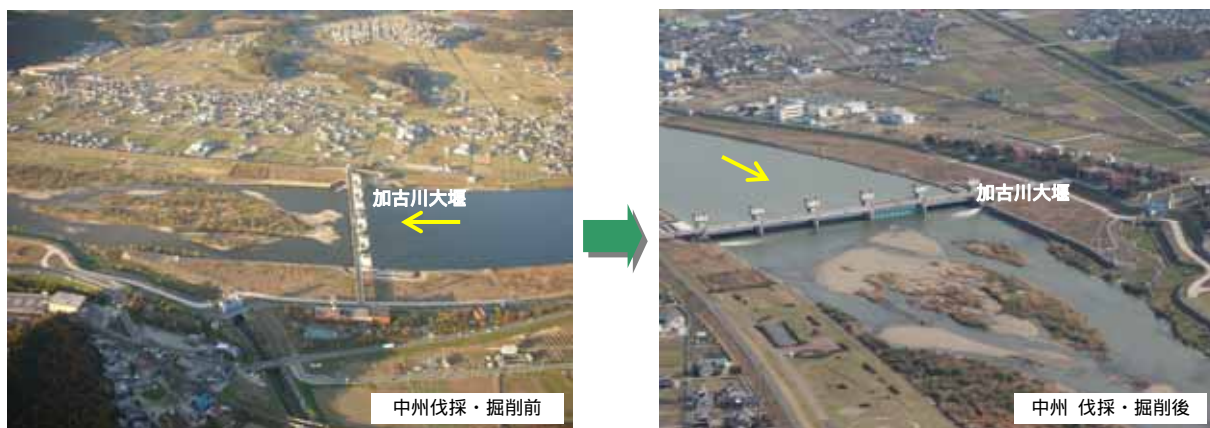
写真 4.2-1 堰直下の現状
