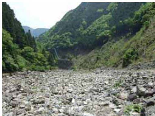
下流河川の調査地区
