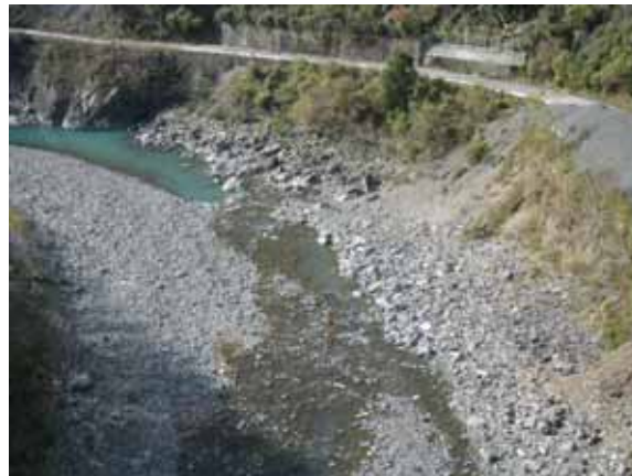
下流河川の状況（平成 24 年 11 月 28 日撮影）
