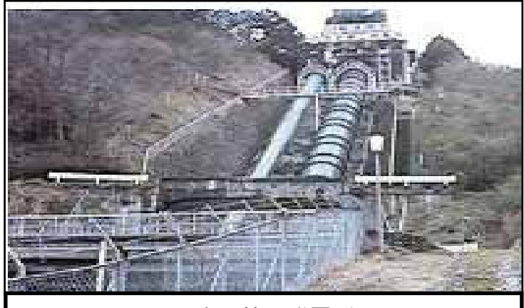
西吉野第二発電所
