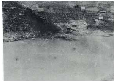
大字谷垣内山崩れ、十津川を閉塞
