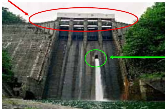
図 1.2.4-3 猿谷ダムの放流設備
