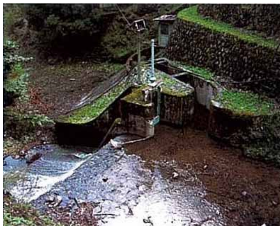
キリキ谷取水堰堤
