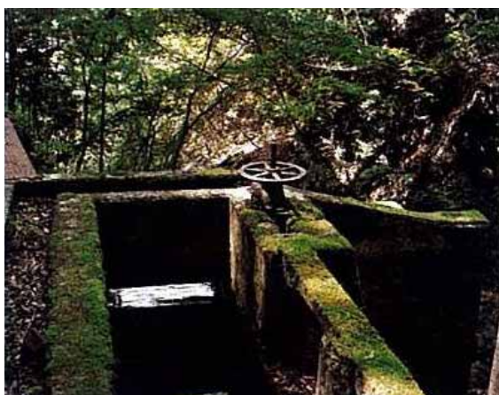
大江谷取水堰堤
