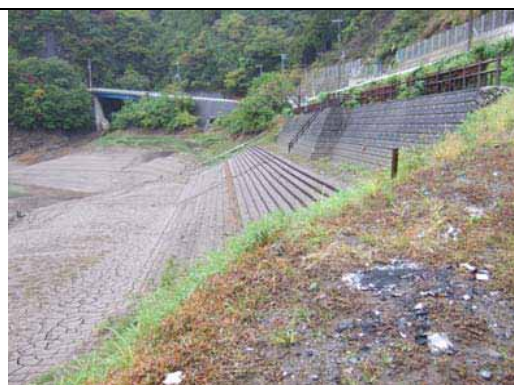
ダム湖内の調査地区(水位変動域)
