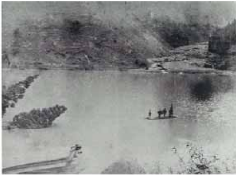
大字林山崩れ、十津川を閉塞
