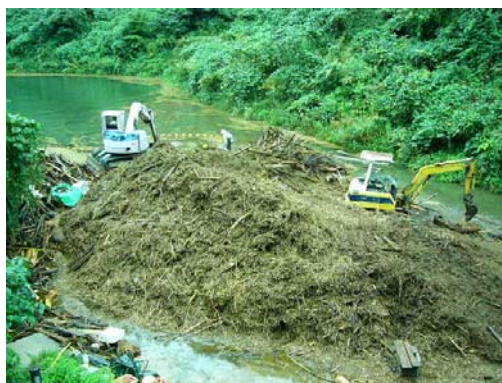
流木処理状況（遠景）
