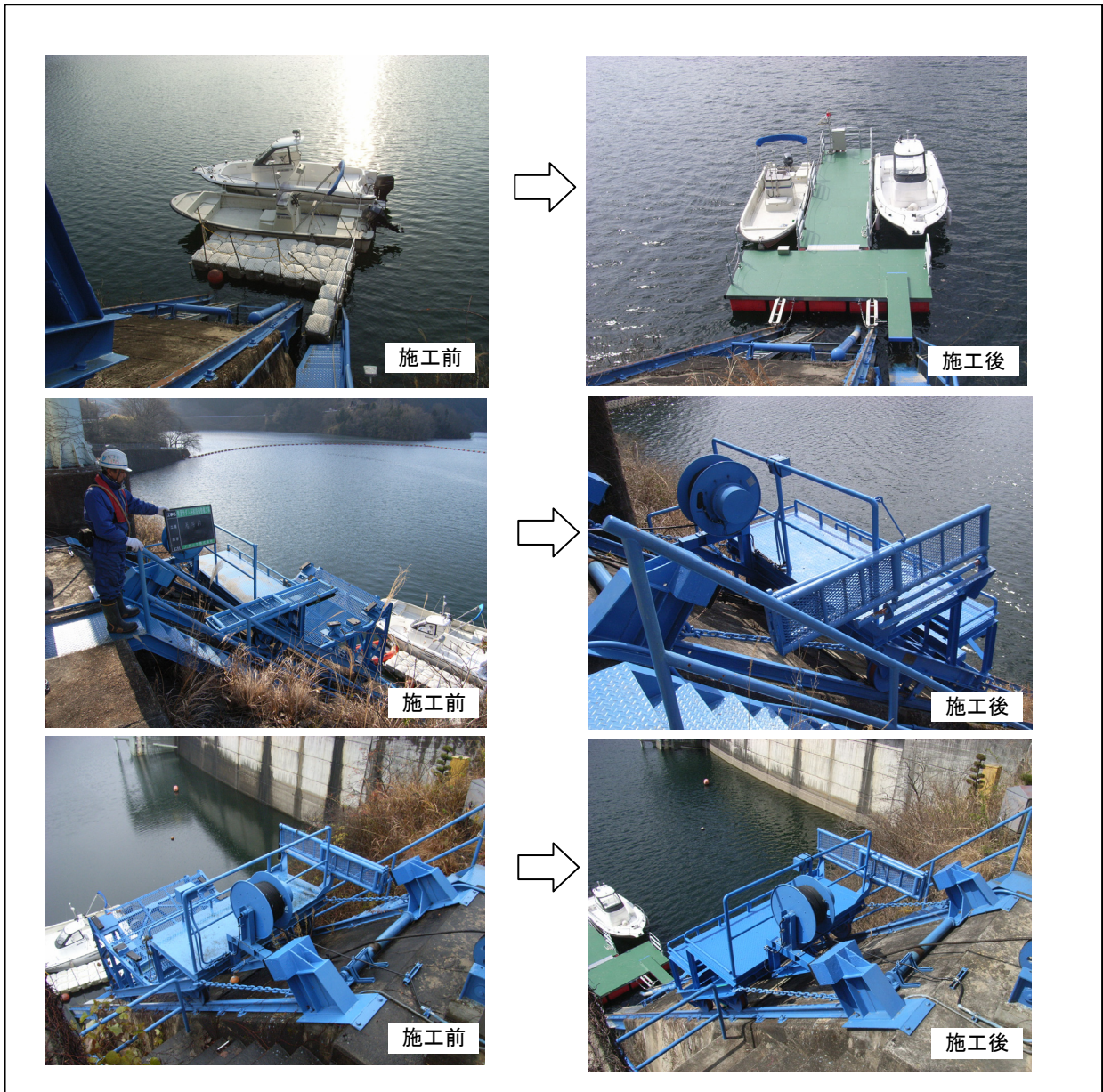
図 1.3.1-3 係船施設整備（平成 18 年度）
