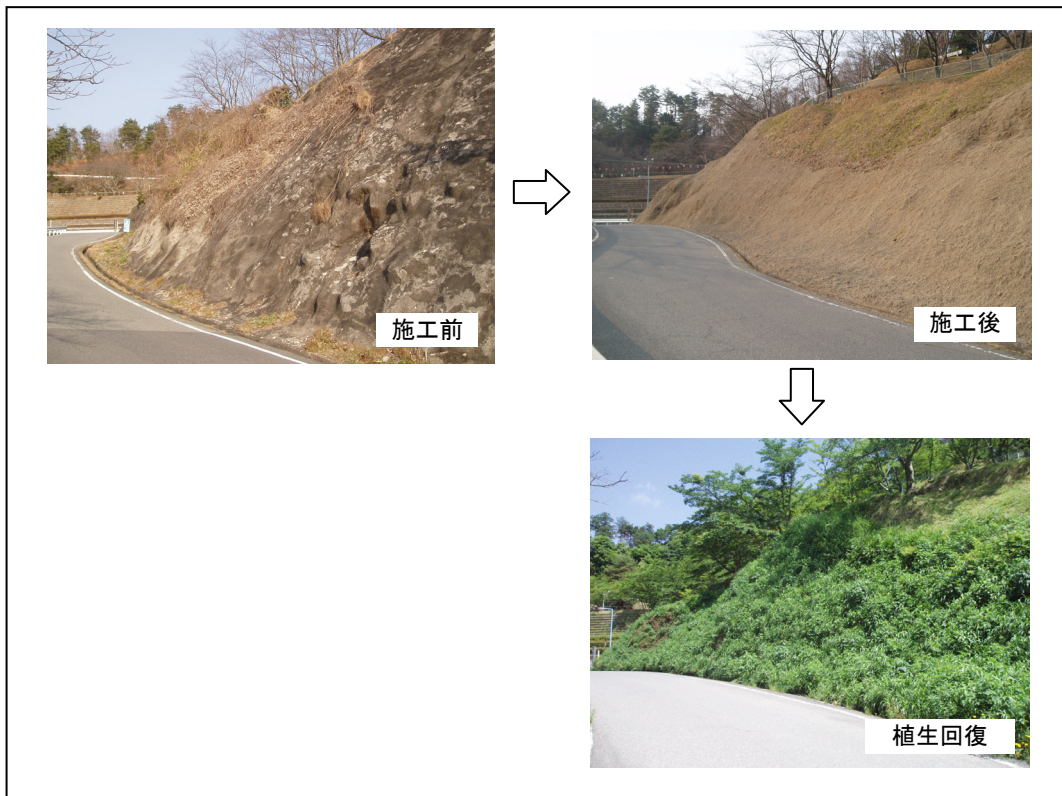
図 1.3.1-7 ダムサイト左岸法面保護工事（平成 18 年度）
