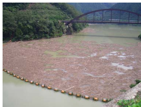
流木発生状況
