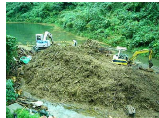
流木処理状況
