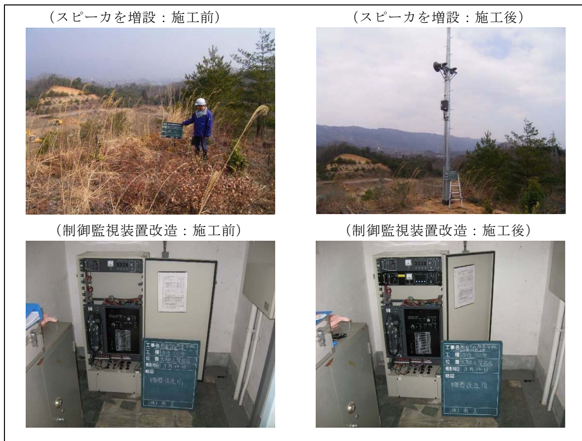
図 1.3.1-25 放流警報設備改造工事 (平成 19 年度)
