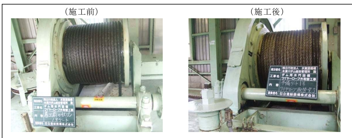
図 1.3.1-18 常用洪水吐予備ゲートワイヤロープ取替(平成 19 年度)
