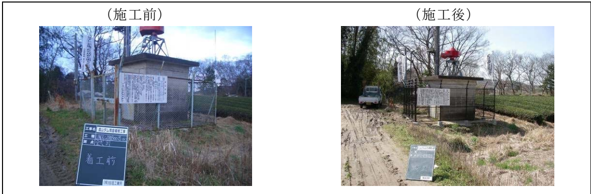
図 1.3.1-34 下流警報局舎補修(平成 20 年度)
