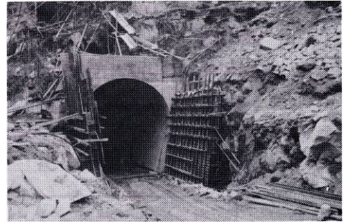
仮排水トンネル工事
