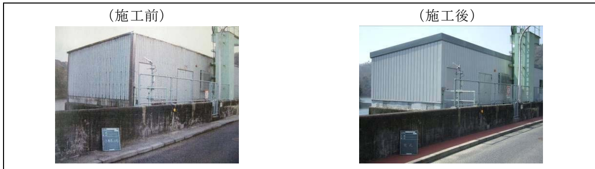
図 1.3.1-39 ダム放流設備建屋改修工事(平成 20 年度)
