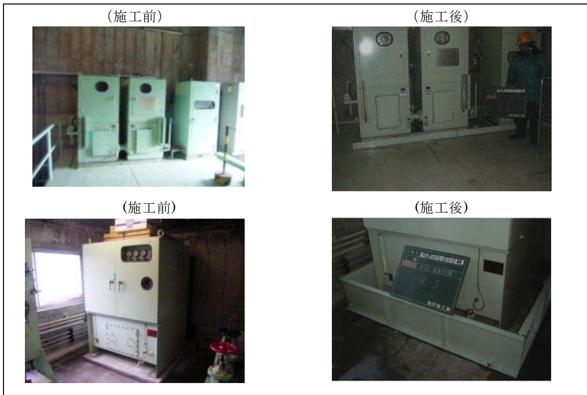
図 1.3.1-12 常用洪水吐設備外防油堤設置(平成 18 年度)
