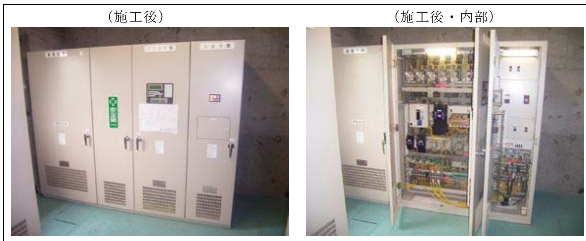
図 1. 3. 1-6 無停電電源装置整備工事(平成 18 年度)
