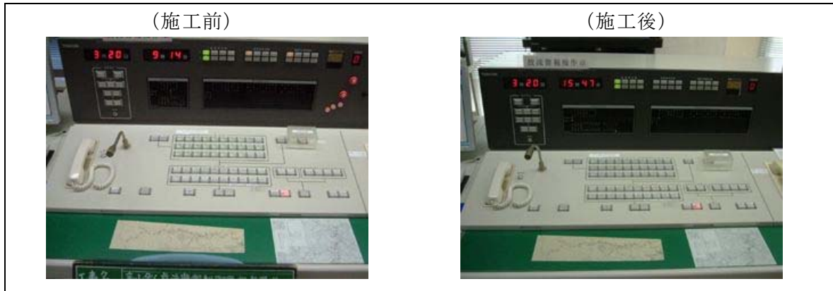
図 1.3.1-10 放流警報設備改造工事(平成 18 年度)
