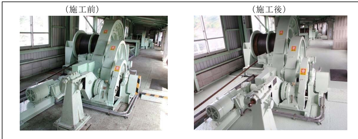
図 1. 3. 1-19 非常用洪水吐設備塗装(平成 19 年度)
