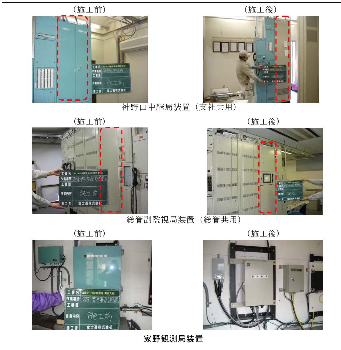
図 1.3.1-17 テレメータ設備更新(平成 19 年度)
