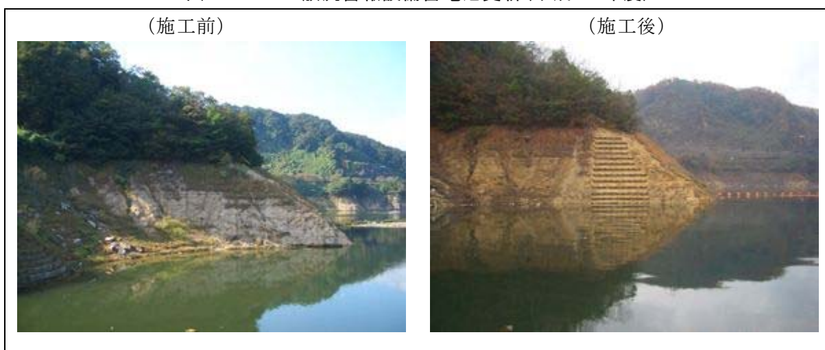
図 1. 3. 1-8 法面对策工事(平成 18 年度)
