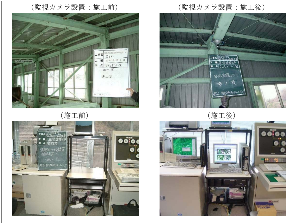
図 1.3.1-26 管理施設防犯対策整備(平成 19 年度)
