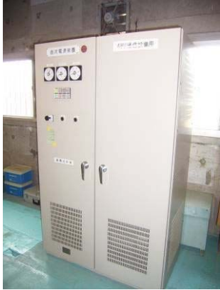
(始動用直流電源設備：施工前)
