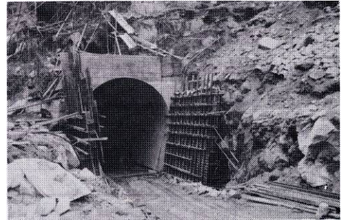
仮排水トンネル工事
