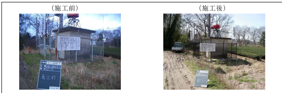
図 1.3.1-34 下流警報局舎補修(平成 20 年度)
