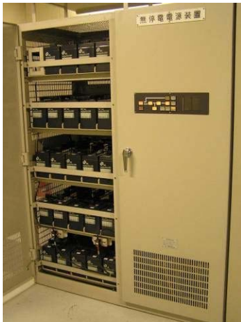
図 1.3.1-36 無停電電源設備更新(平成 20 年度)
