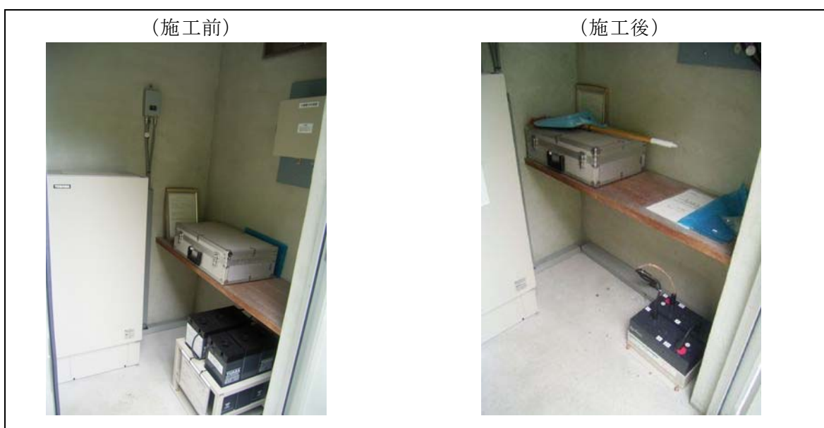
图 1.3.1-7 放流警報設備蓄電池更新(平成 18 年度)
