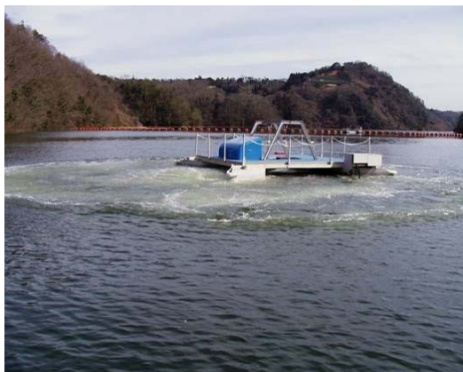
＜曝気循環設備＞
