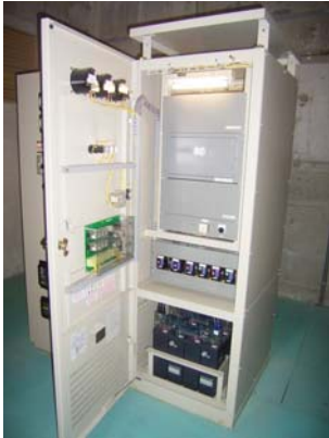
(始動用直流電源設備：施工前)
