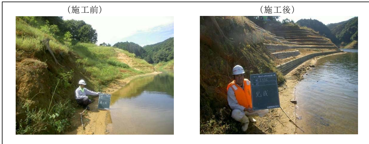
图 1.3.1-22 法面对策工事(平成 19 年度)
