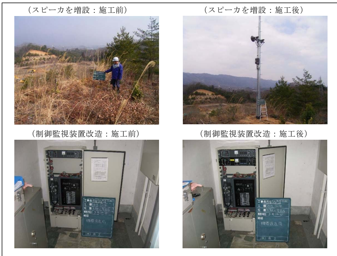
図 1.3.1-25 放流警報設備改造工事 (平成 19 年度)
