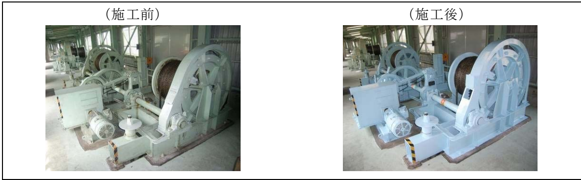
図 1.3.1-28 常用洪水吐き設備塗装(平成 20 年度)
