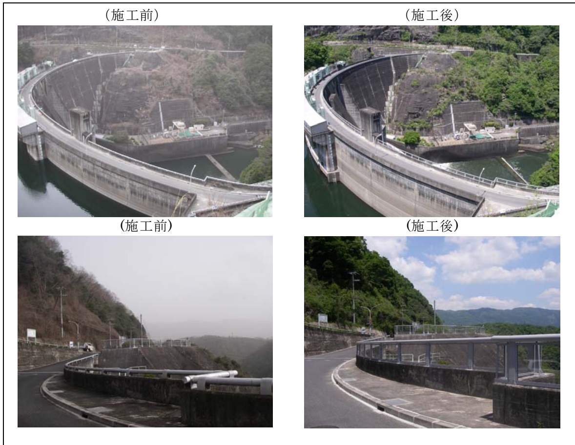
图 1.3.1-9 天端高欄整備工事(平成 18 年度)
