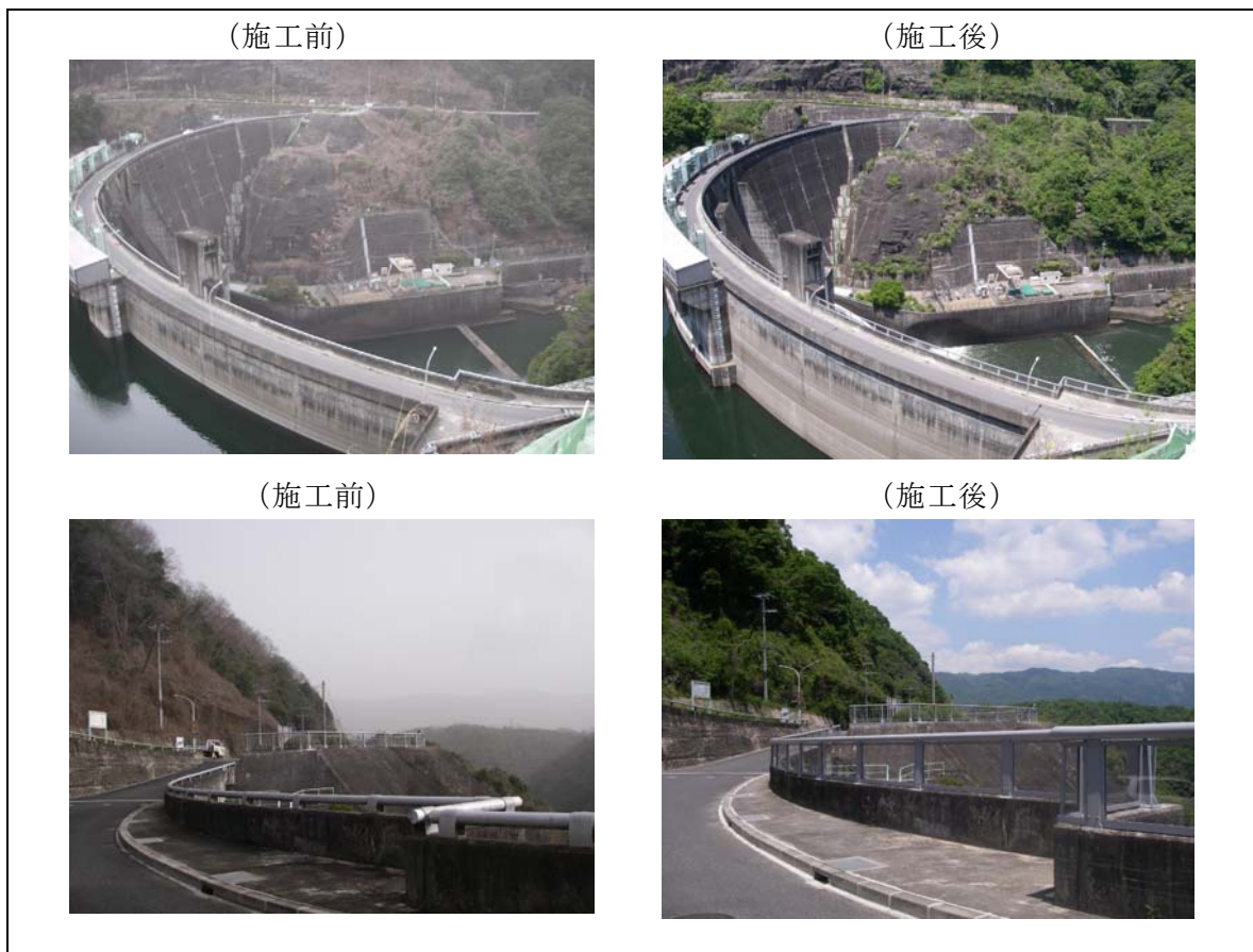
图 1.3.1-23 天端高欄整備工事(平成 19 年度)
