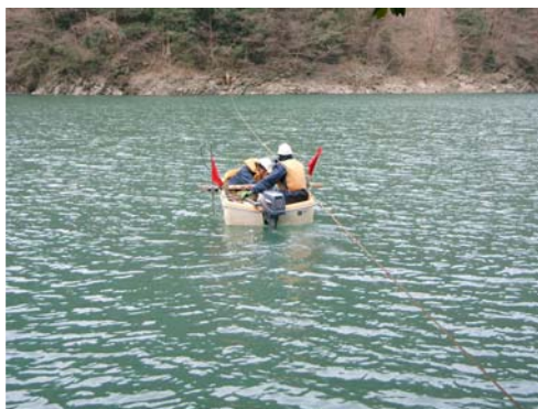
図 4.2-2 深浅測量作業状況
