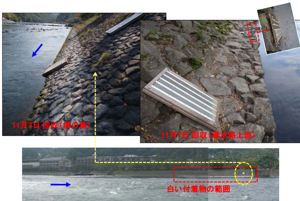
図 5.3-45 付着板設置状況
