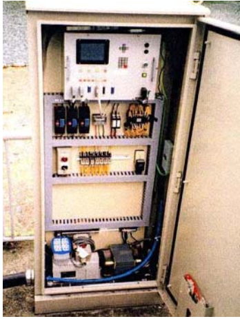
図 5.2-5(1) ダムサイト地点水質自動観測装置(操作盤・センサー部・立面図)
