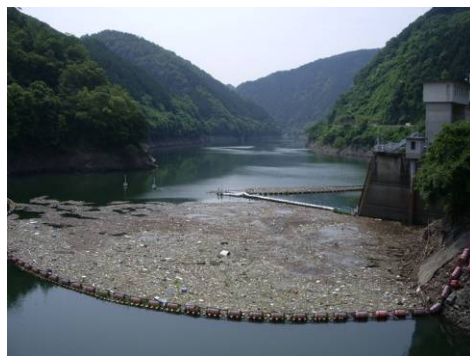
ダムサイト近傍の既設網場
