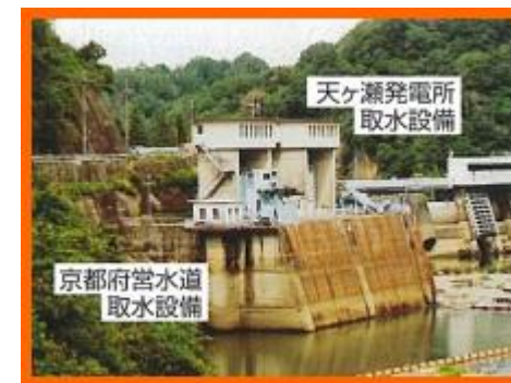
ダム地点取水設備
