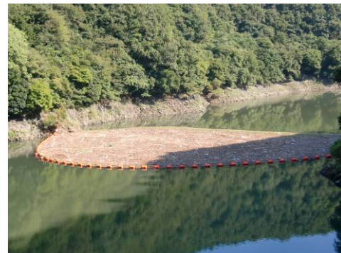
上流の新設網場
