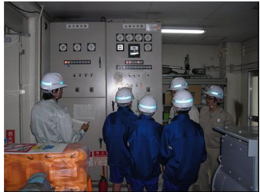
中学生の職場体験(機器設備点検状況)
