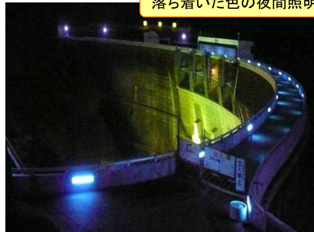
堤頂通路の夜間照明
