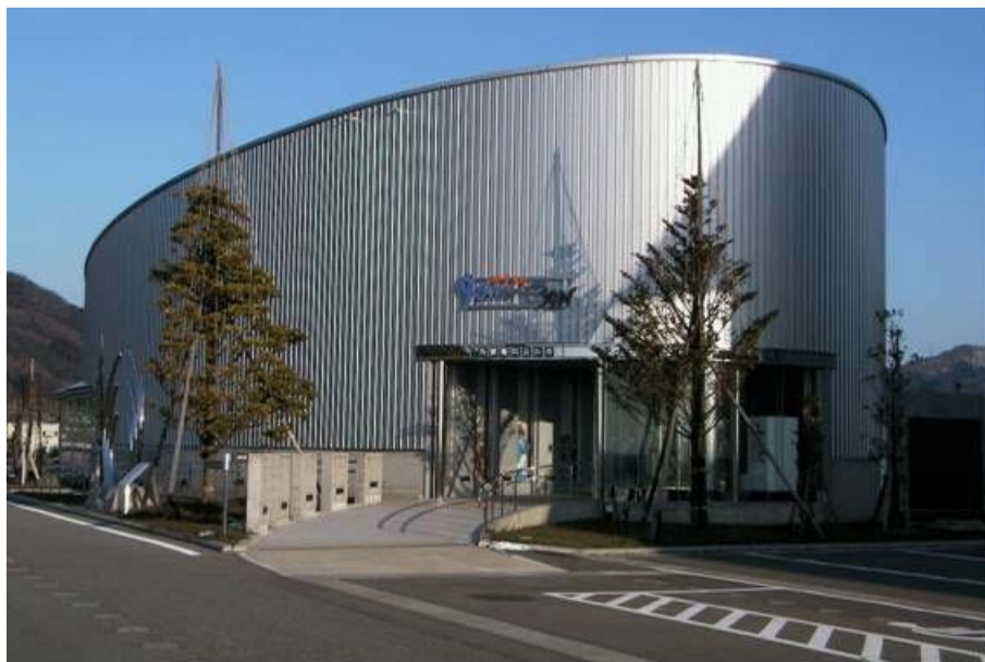
図 7.4-1 九頭竜川流域防災センターの外観
