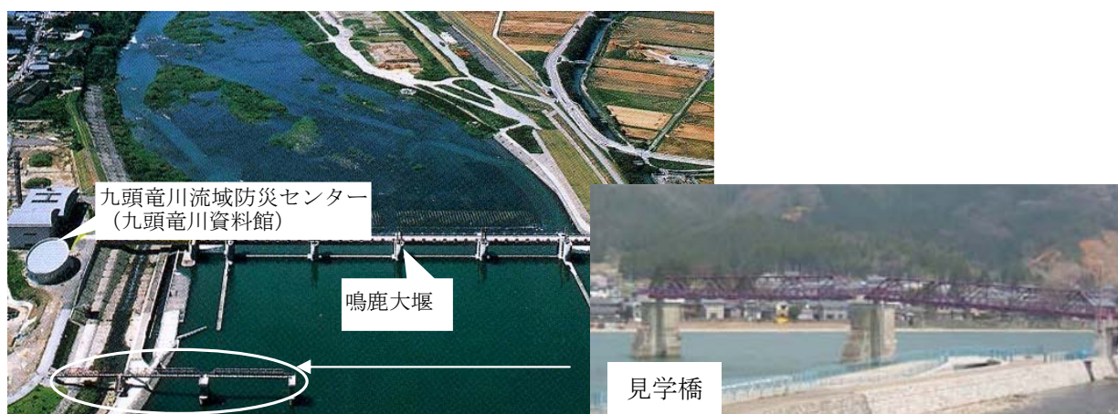
図 7.4-4 一般解放区及び見学橋の外観
