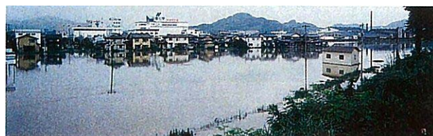
浸水状況（浅水川左岸御幸町内）
