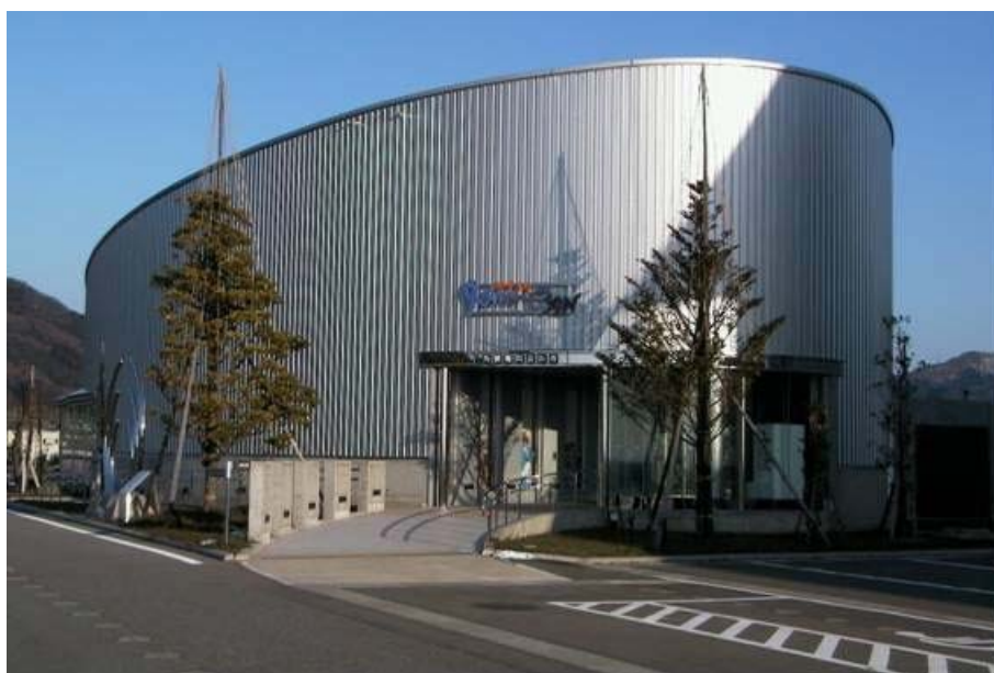
図 2.5.3 九頭竜川流域防災センターの外観
