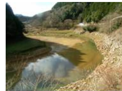
浚渫状況(箇所①)
