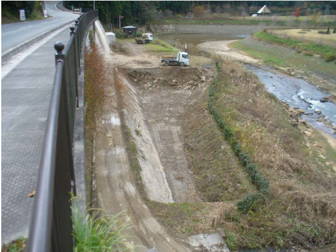
図 2-4-5 上流ストックヤード写真 (ストック量 : 約 1,300m 3 )
