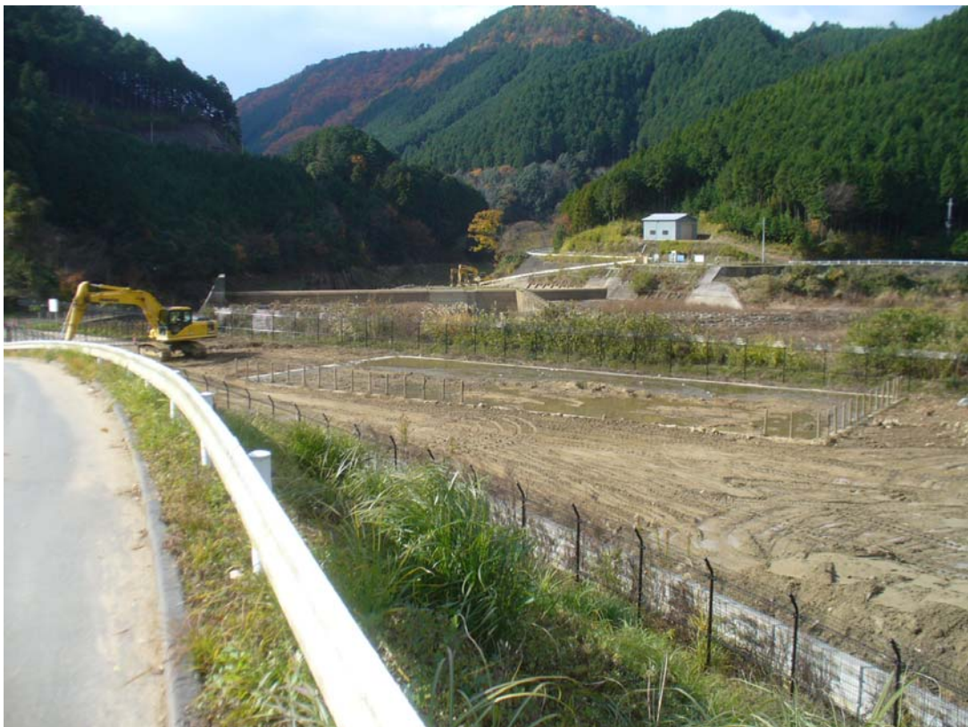
図 2-4-6 下流ストックヤード写真 (ストック量 : 約 300m 3 )
