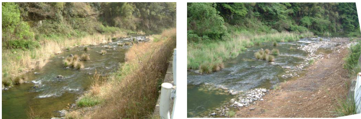
写真 6.5.2-1 ヨシの除去と玉石の投入対策前(左)と対策後(右)の状況
