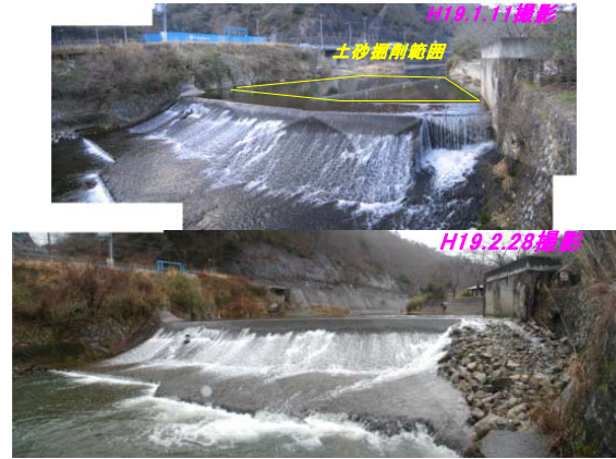
写真 6. 5. 3-2 貯水池上流(一庫大路次川)旧堰堤での土砂掘削 (左:位置図、右:掘削前後の様子)
