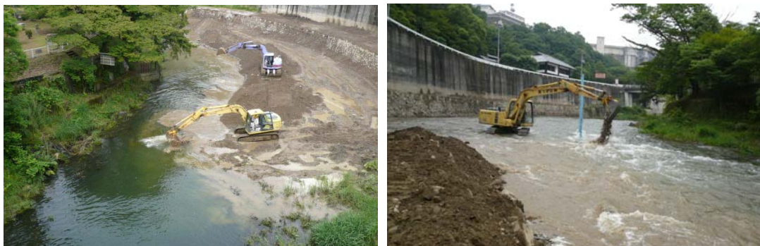
写真 6. 5. 3-3 平成 20 年のフラッシュ放流状況
