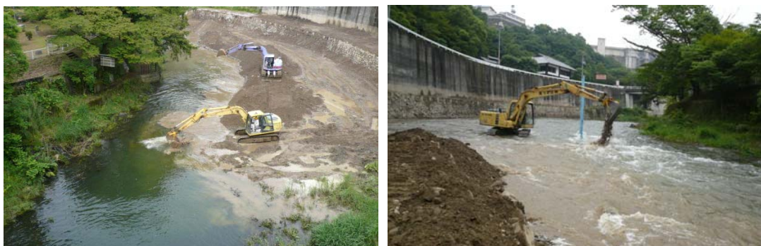
写真 6. 5. 3-3 平成 20 年のフラッシュ放流状況
