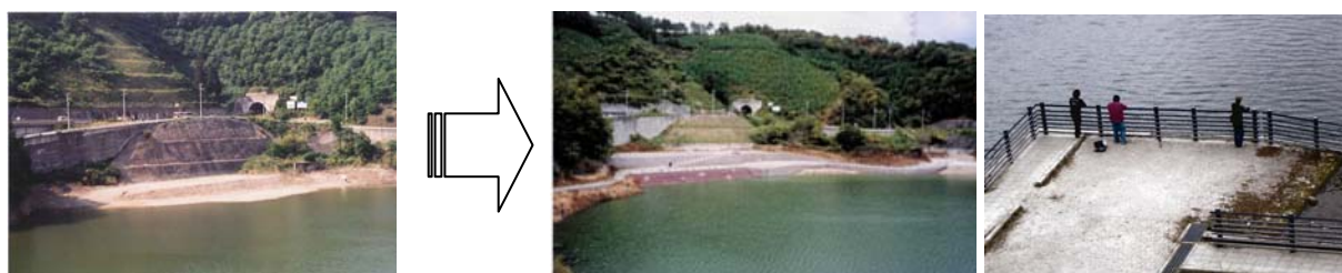
写真 1.2-2 出合地区の整備前(左)及び整備後(中央・右)
