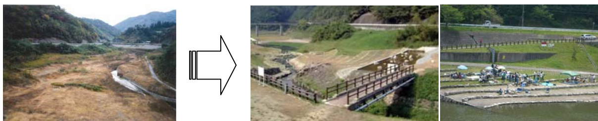
写真 1.2-1 国崎地区の整備前(左)及び整備後(中央・右)
